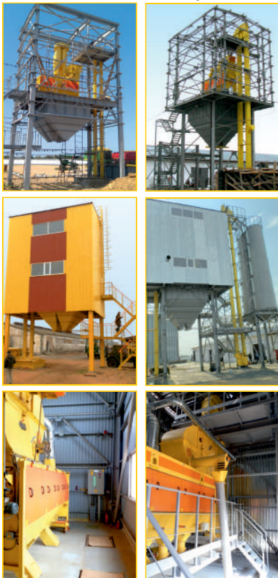
ЗАВ-«Нива»-25 ЗАВ-«Нива»-50 Этапы монтажа и запуска
